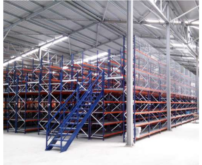
Escalera de acceso a entreplanta
