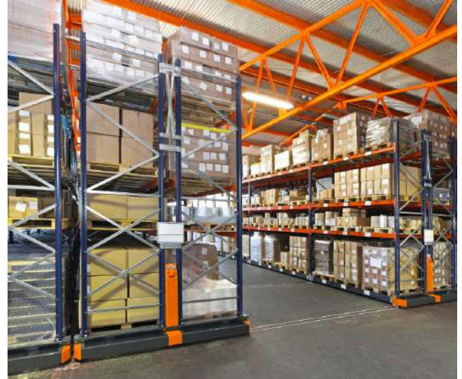
Sistema muy utilizado en cámaras frigoríficas
